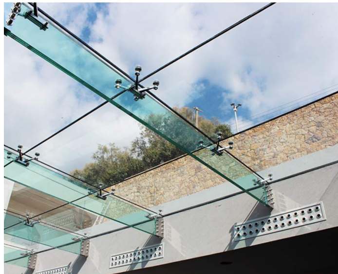
Slika 20 Staklene grede (20)
