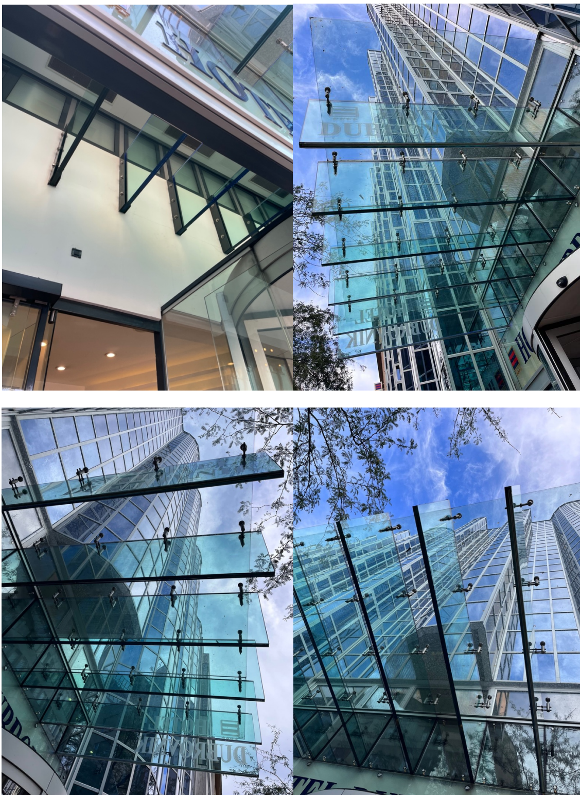
Slika 27 Prikaz staklene nadstrešnice
