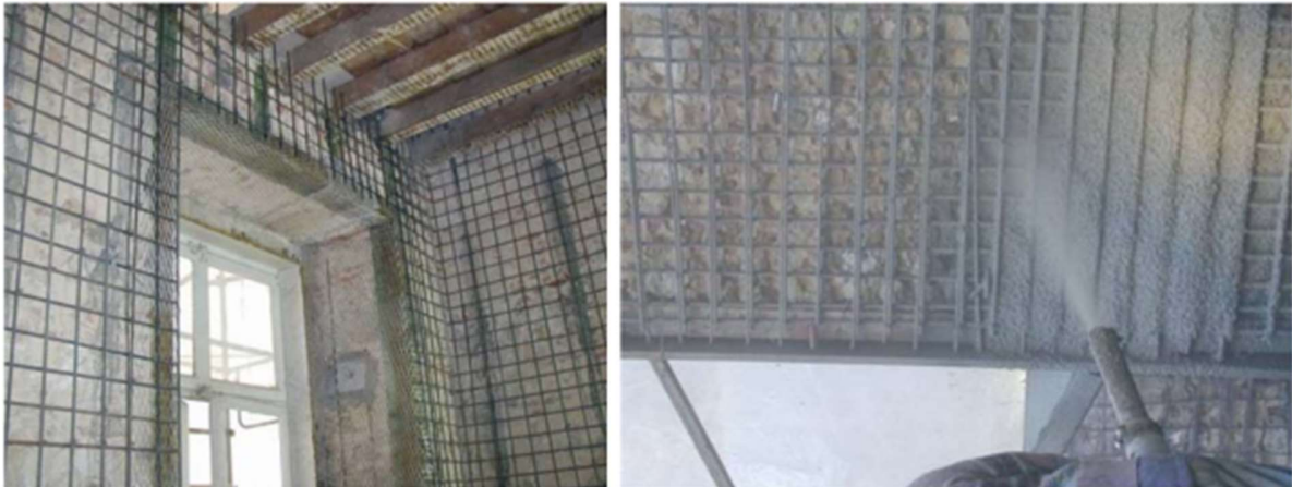
Slika 62. Armiranje obloge(lijevo), torkretiranje(desno) (32)
