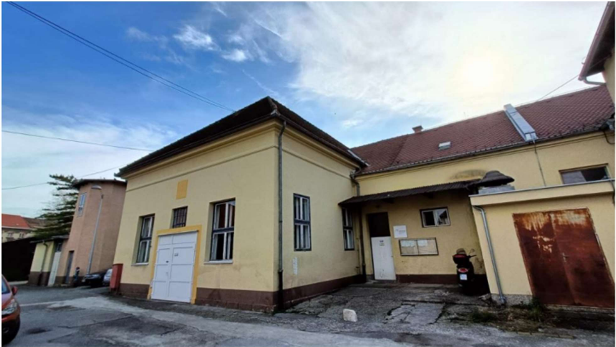
Slika 15. Prikaz sjeverozapadnog pročelja građevine
