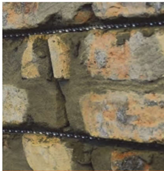
Slika 55. Umetanje čeličnih šipki (28)
