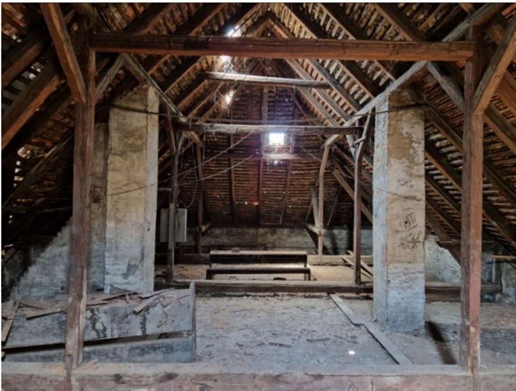
Slika 24. Dvostruka visulja nad središnjim dijelom građevine
