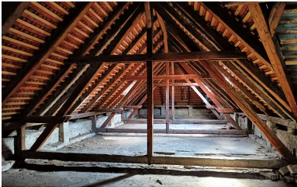
Slika 23. Prikaz jednostruke visulje nad sjevernim krilom zgrade
