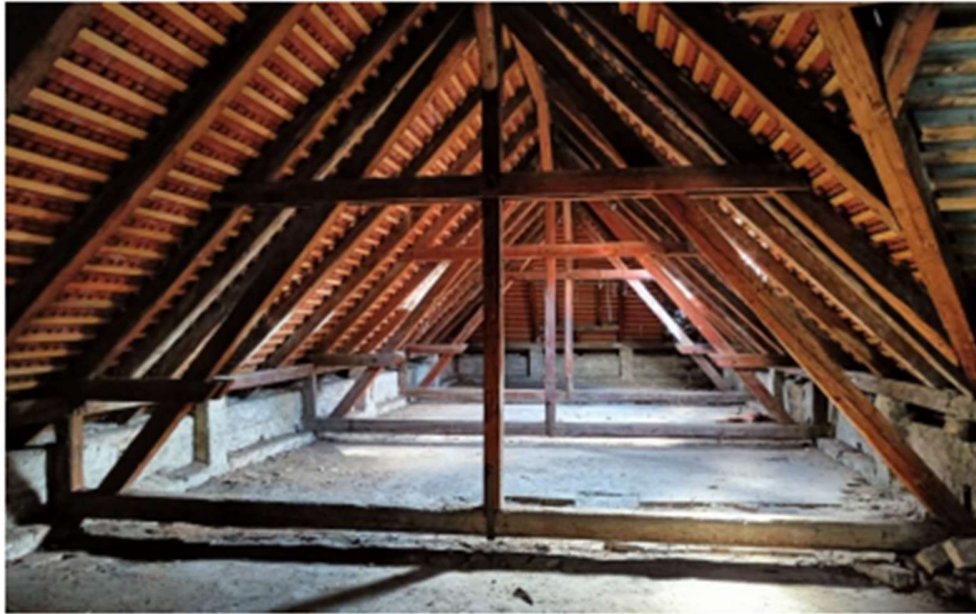
Slika 23. Prikaz jednostruke visulje nad sjevernim krilom zgrade
