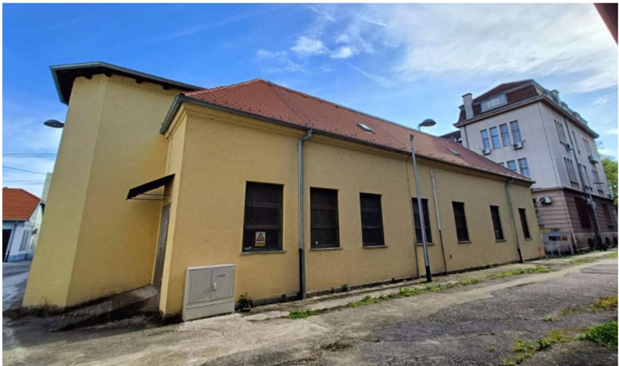
Slika 16. Prikaz jugoistočnog pročelja građevine
