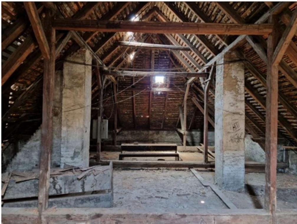
Slika 23. Prikaz jednostruke visulje nad sjevernim krilom zgrade
