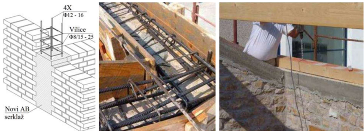
Slika 58. Prikaz izvedbe serklaža od ideje do izvedbe
