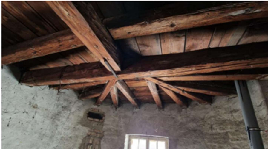
Slika 25. Prikaz ravnog krova nad kupolom na zapadnom pročelju
