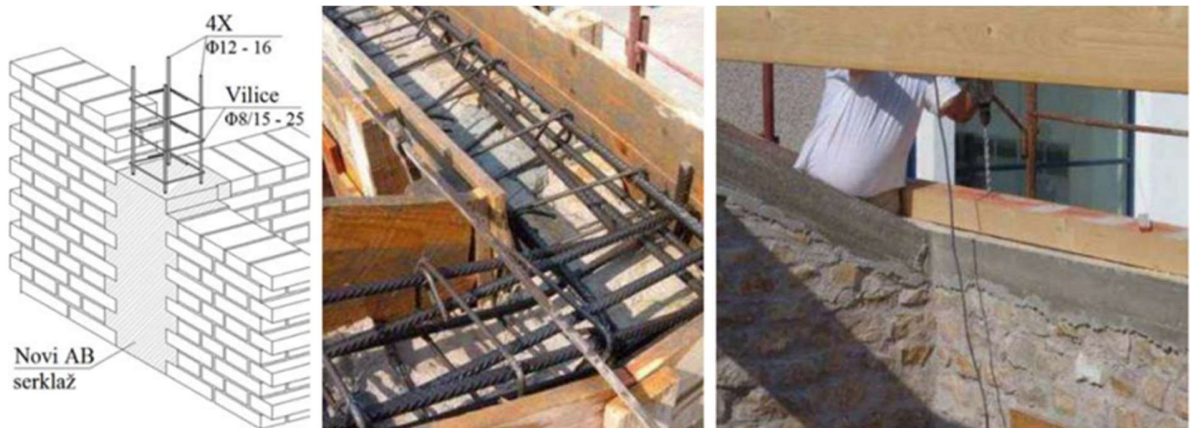
Slika 58. Prikaz izvedbe serklaža od ideje do izvedbe
