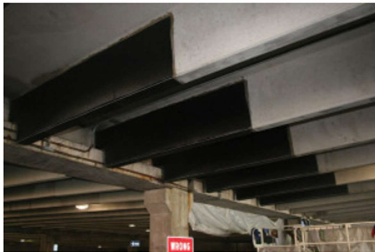
Slika 60. Ojačanje greda u jednoj garaži (36)
