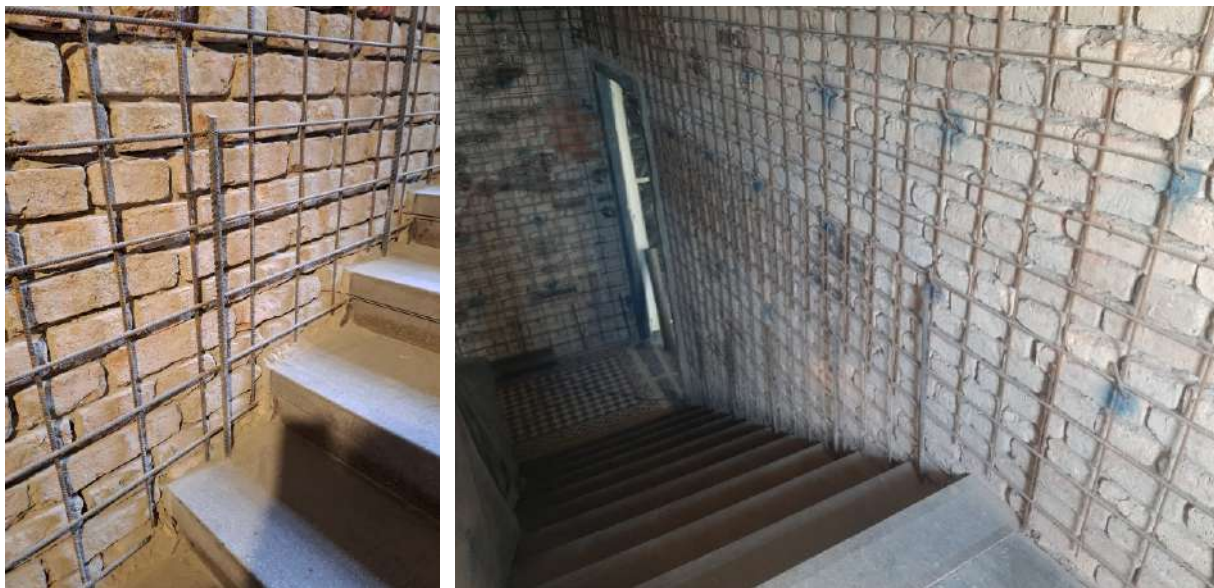
Slika 10 Armiranje zidova prije mlaznog betona
