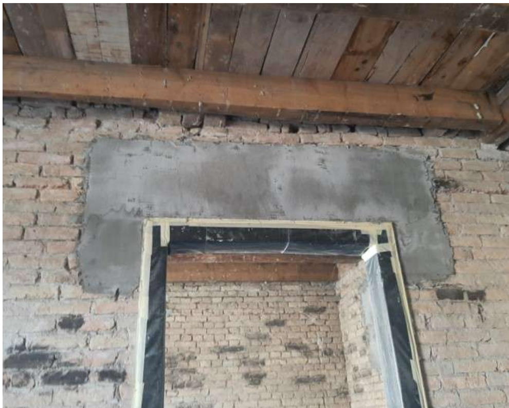
Slika 13 Saniranje nadvoja FRCM sustavom
