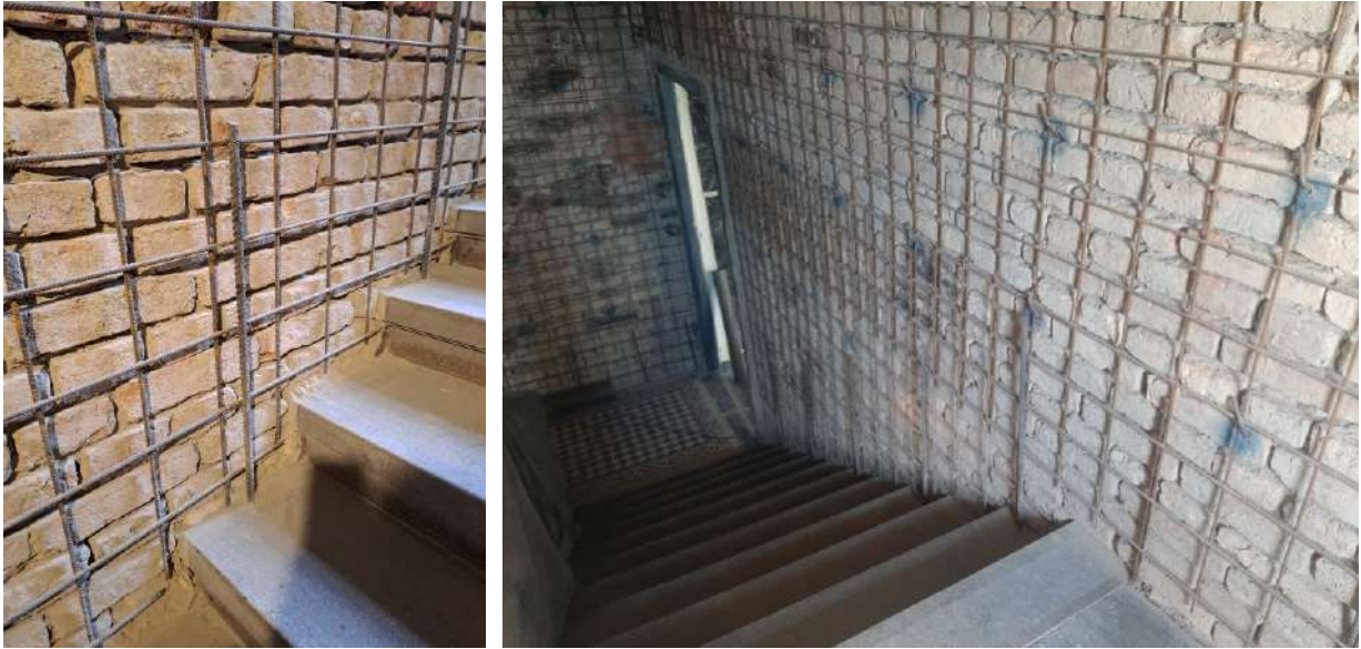
Slika 10 Armiranje zidova prije mlaznog betona
