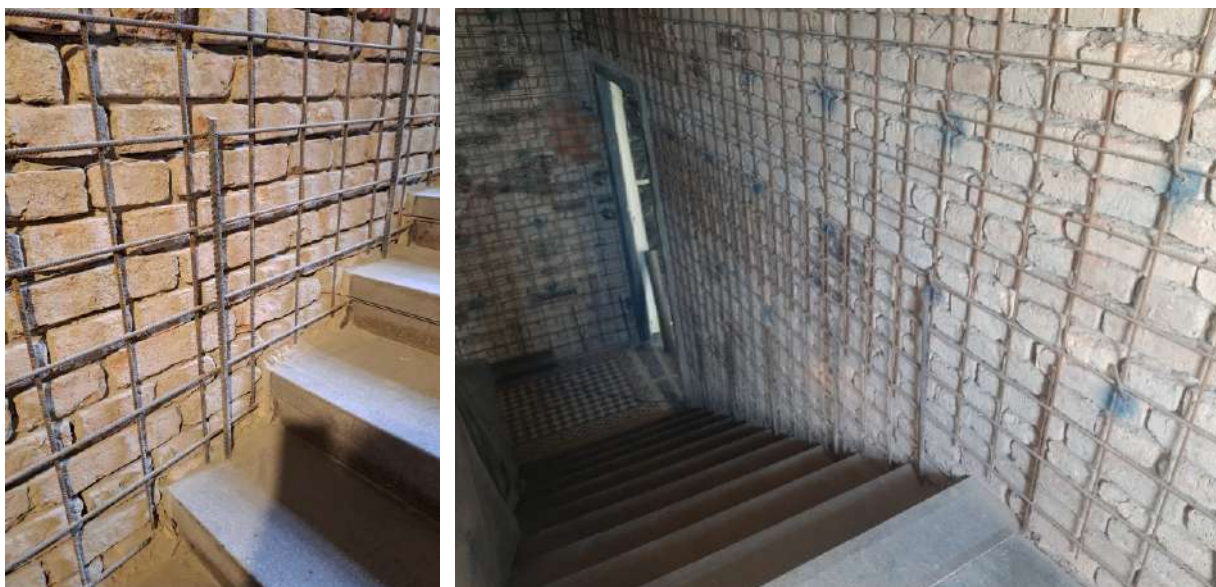
Slika 10 Armiranje zidova prije mlaznog betona
