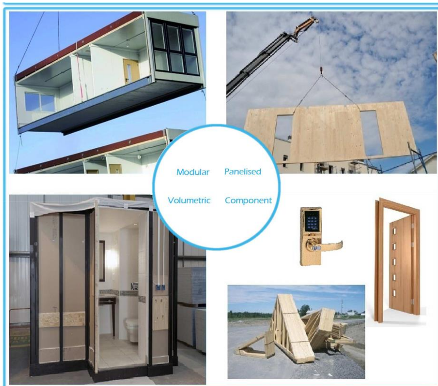
Slika 4 Klasifikacija prefabrikacije (Atamate Ltd, 2021)
