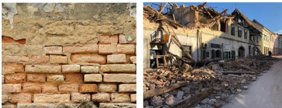
Slika 14 Primjer nekvalitetne gradnje (lijevo) i posljedice iste (desno) [13]
