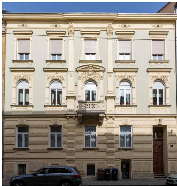
Slika 4 Prikaz prednje fasade zgrade [1]
