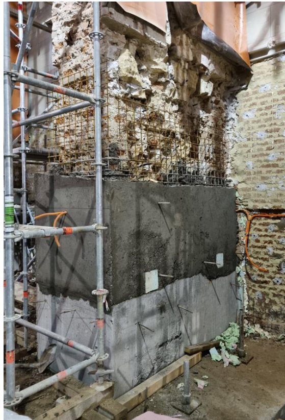
Slika 37. Prikaz izvedbe armiranobetonske obloge kontrafora (Foretić, 2021)
