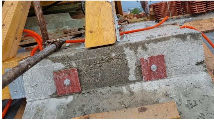
Slika 53. Sidrene pločice i vijci ugrađenih zatega (Foretić, 2021)
