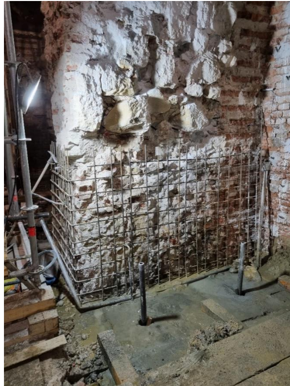
Slika 34. Ugrađena geotehničkih sidara (Foretić, 2021)
