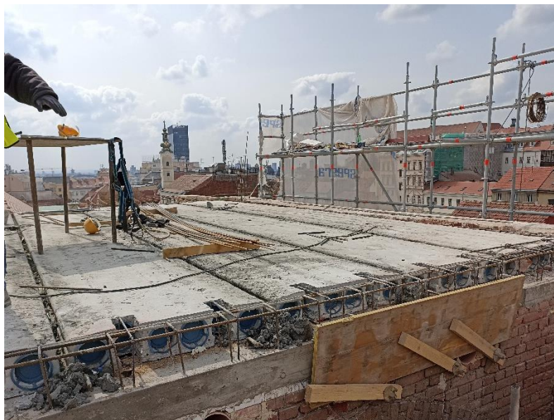
Slika 51. Izvedba predgotovljenih šupljih ploča (Foretić, 2021)
