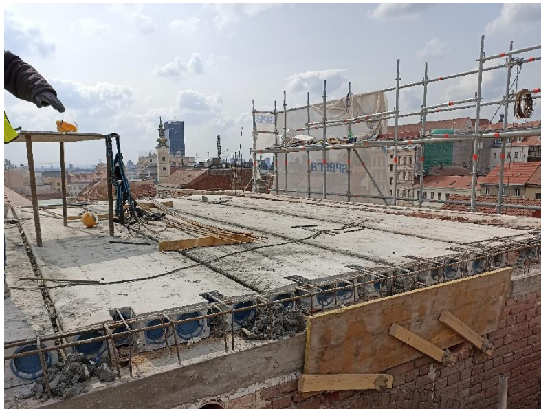
Slika 51. Izvedba predgotovljenih šupljih ploča (Foretić, 2021)
