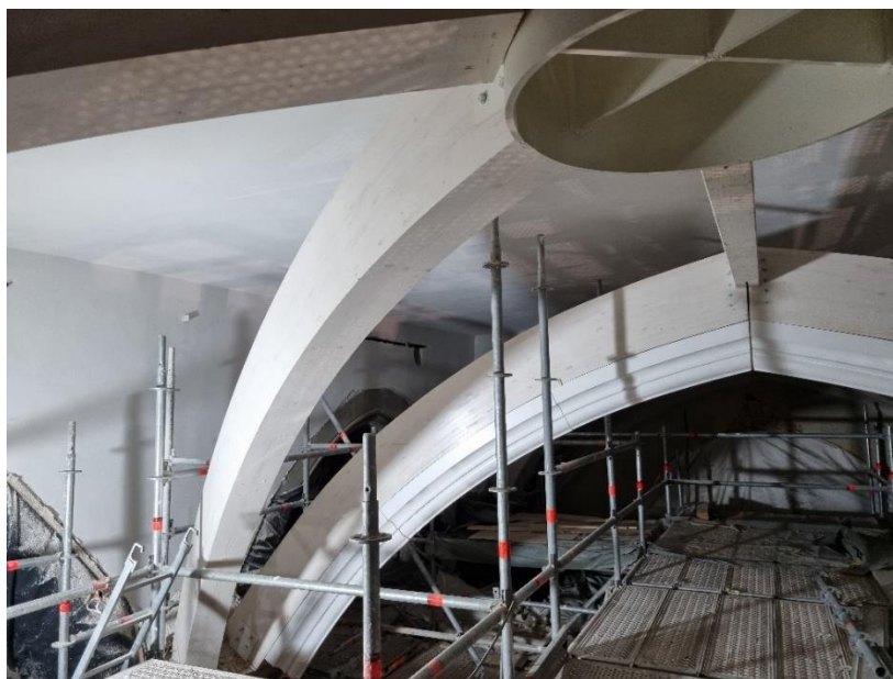
Slika 49. Detalj LLD nosača s pogledom iz unutrašnjosti crkve (Foretić, 2021)
