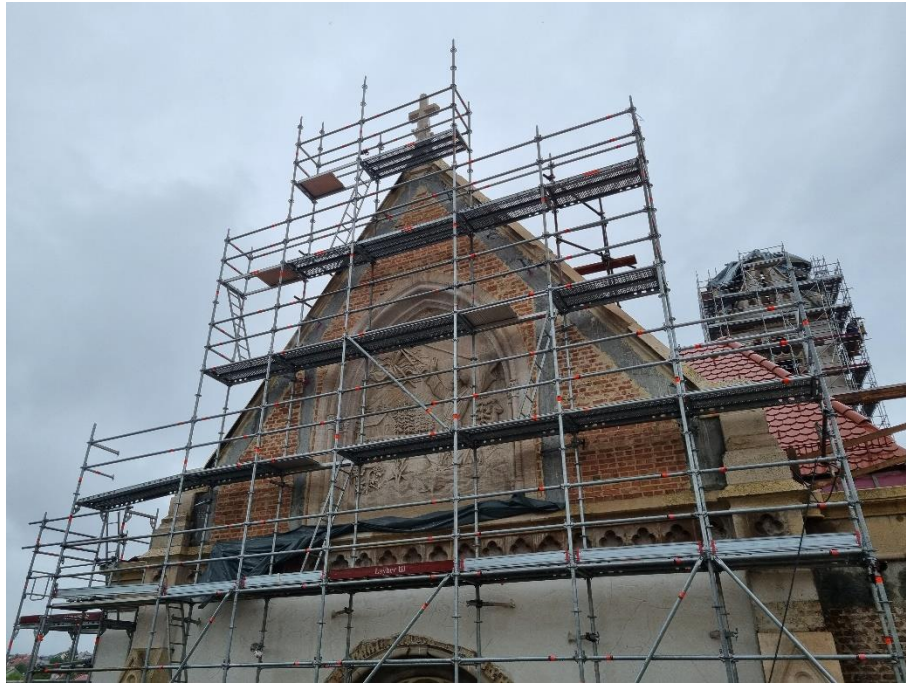
Slika 38. Izvedba armiranobetonskih serklaža na zabatnom zidu crkve (Foretić, 2021)
