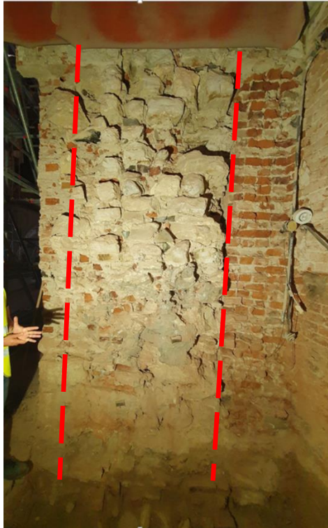
Slika 39. Različite faze gradnje kontrafora (Foretić i Trogrlić, 2021)
