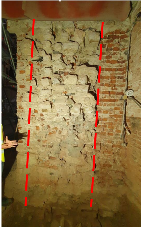
Slika 39. Različite faze gradnje kontrafora (Foretić i Trogrlić, 2021)
