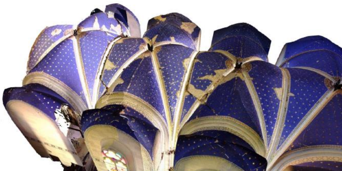
Slika 20. Prikaz sloma svodova (lukova, uvala i grebena) metodom laserskog skeniranja (Foretić i Trogrlić, 2021)
