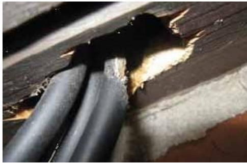
Slika 17 Oštećenje vodova (31)
