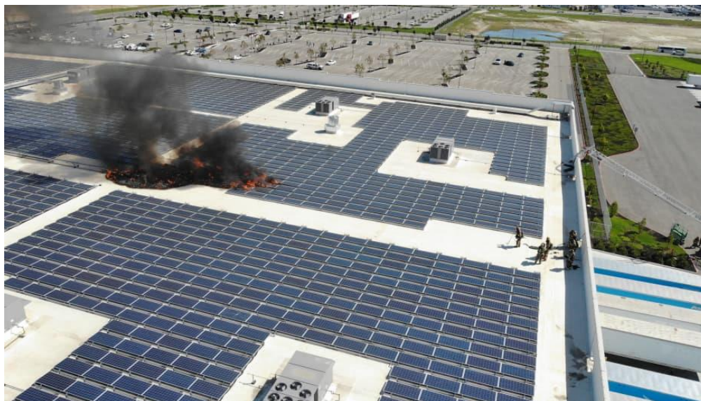
Slika 9 Širenje požara na krovu (24)
