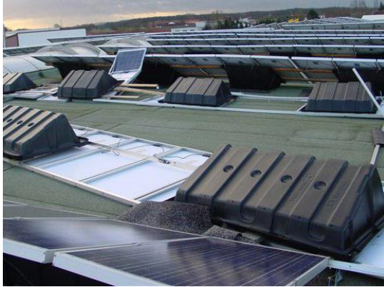
Slika 20 Uništeni moduli u oluji (11)
