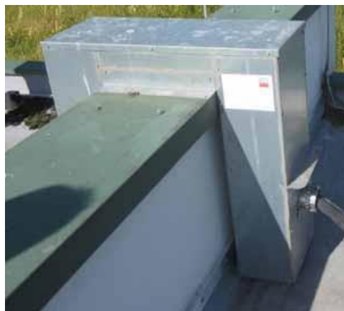
Slika 15 Postavljanje kablova preko požarnog zida uz pomoć protupožarnih kanala (31)
