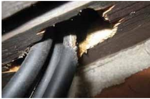
Slika 17 Oštećenje vodova (31)
