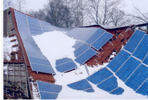
Slika 21 Uništeni moduli zbog snijega (11)
