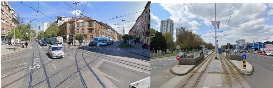
Slika 1. a) kolosijek u sastavu cestovne prometnice b) kolosijek u zasebnom koridoru
