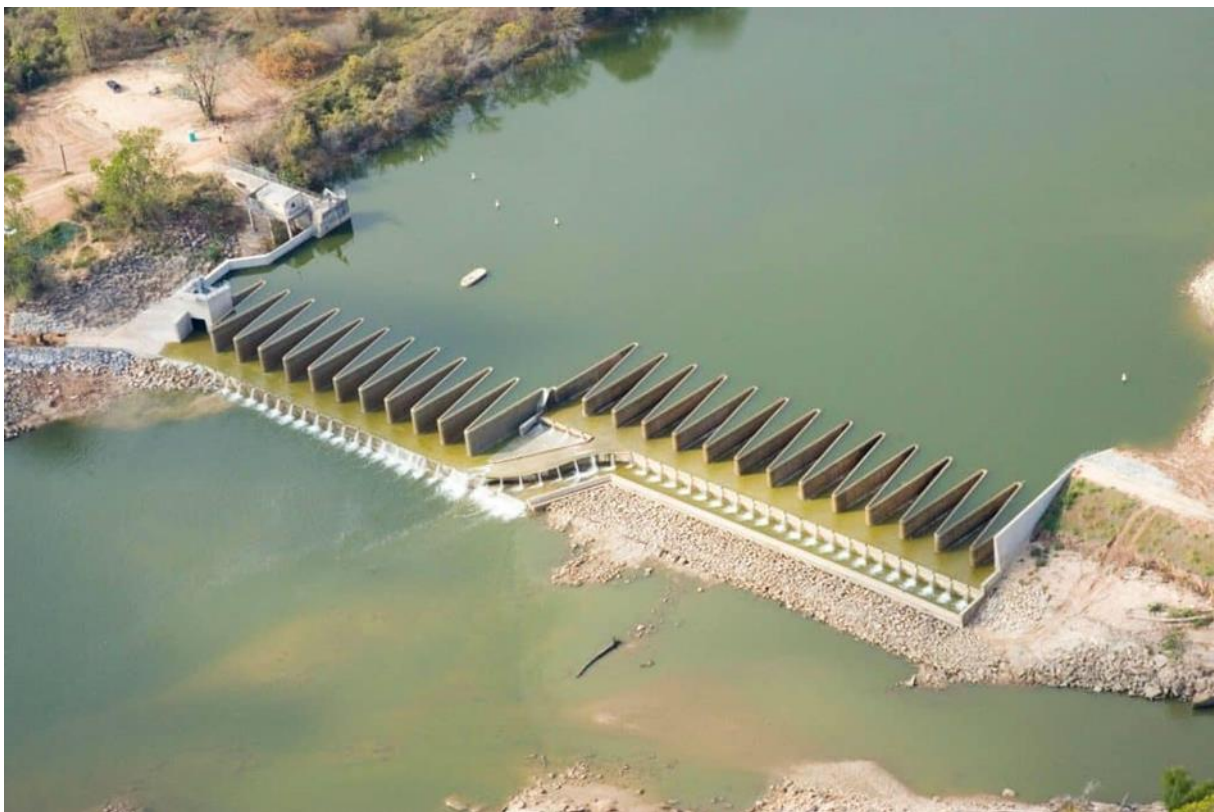
Slika 5. Labirintski preljev[5]
