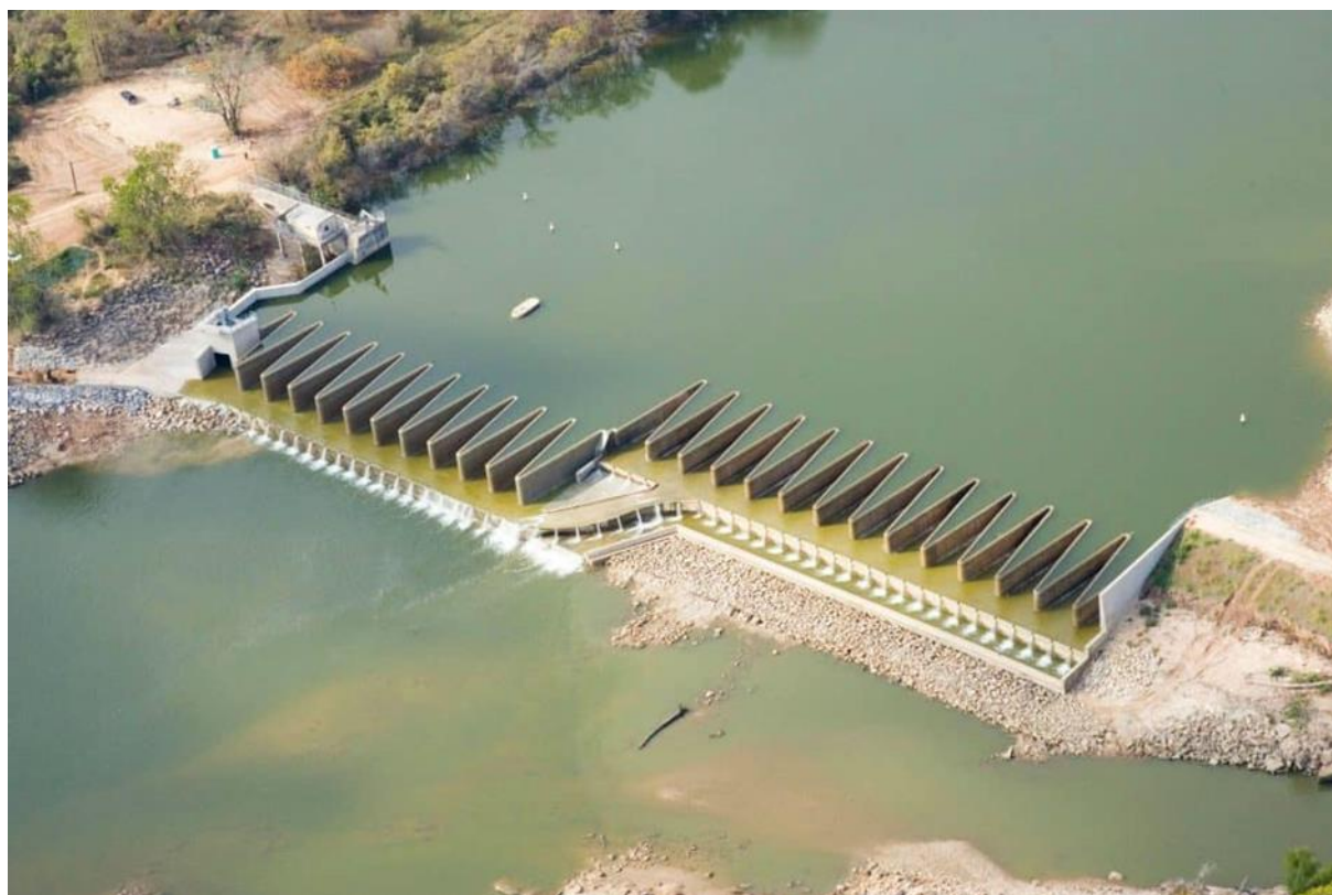
Slika 5. Labirintski preljev[5]
