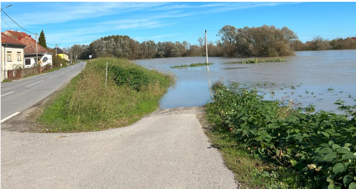
Slika 3. Pogled na prilaznu cestu rampi i mjesto upornjaka U2 na desnoj obali
