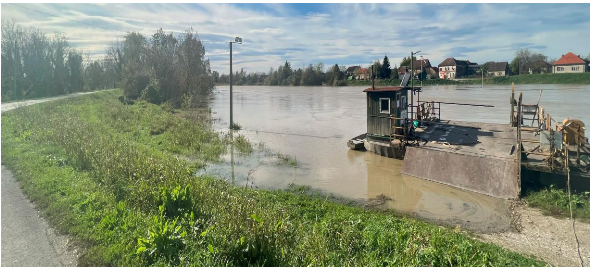
Slika 4. Pogled na lokaciju projekta iz naselja Tišina Erdedska i prikaz postojeće skele
