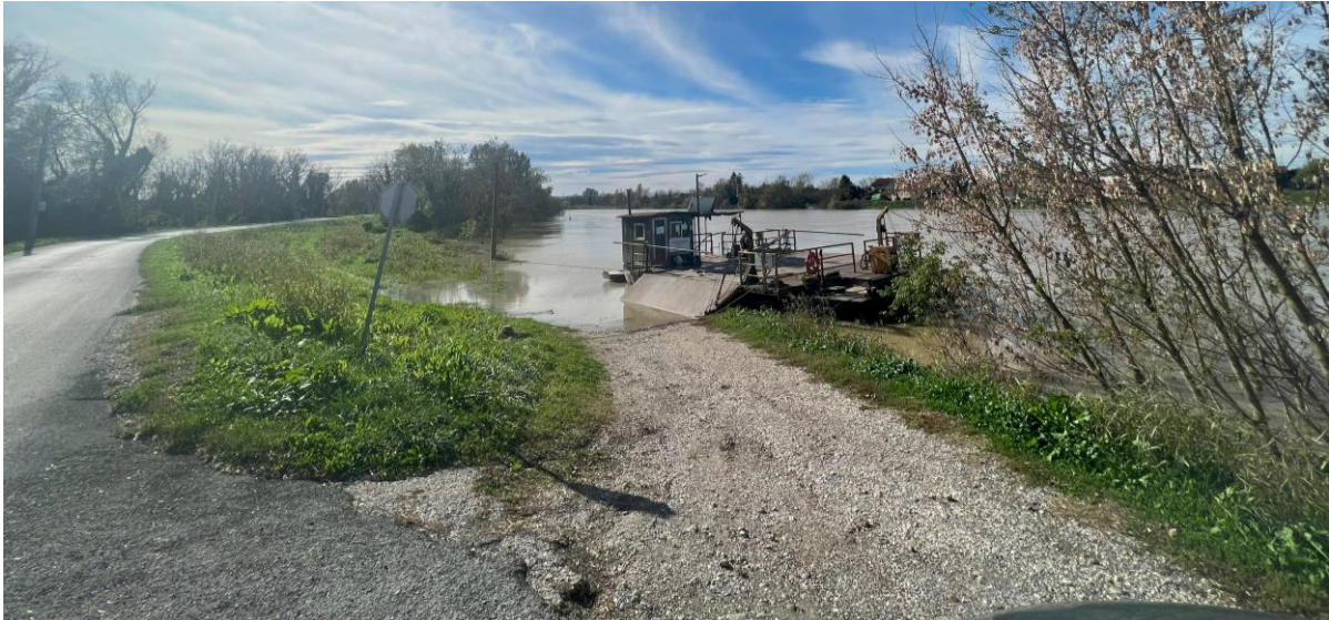
Slika 5. prikaz postojeće skele i mjesta upornjaka U1 na lijevoj obali
