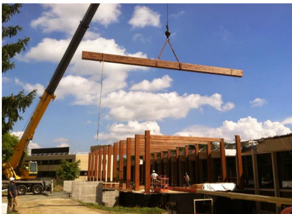
Slika 53. Primjer podizanja drvenih elemenata pomoću autodizalice
