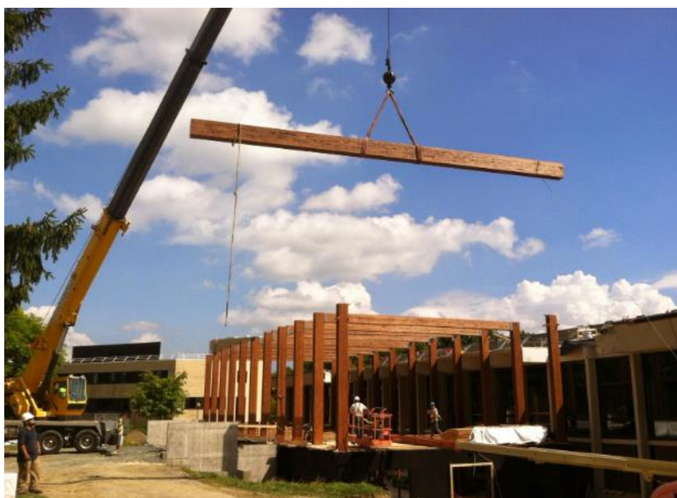
Slika 53. Primjer podizanja drvenih elemenata pomoću autodizalice
