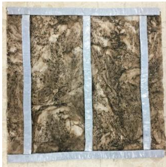
Slika 25: Trake za brtvljenje postavljene duž čeličnih nosača [37]
