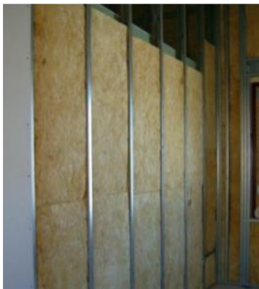
Slika 13: Mineralna vuna između čeličnih nosača
