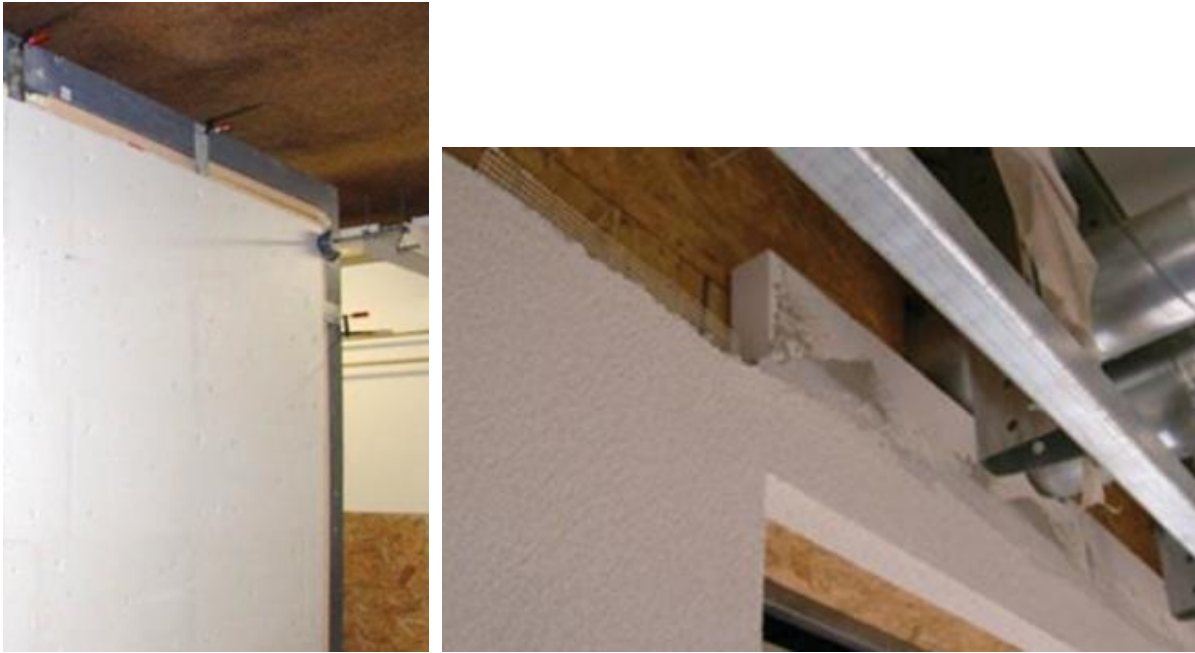
Slika 21: prikaz vanjske toplinske izolacije (EPS) [9]
