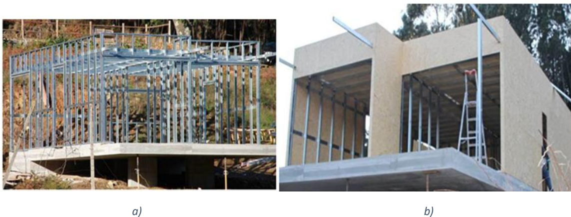
Slika 6 : Primjer stambene zgrade s Laganim čeličnim okvirom tijekom izgradnje [9]. (a) Čelični okvir; (b) vanjski sloj sastavljen od OSB ploča.
