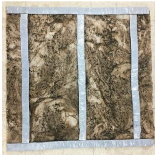
Slika 25: Trake za brtvljenje postavljene duž čeličnih nosača [37]
