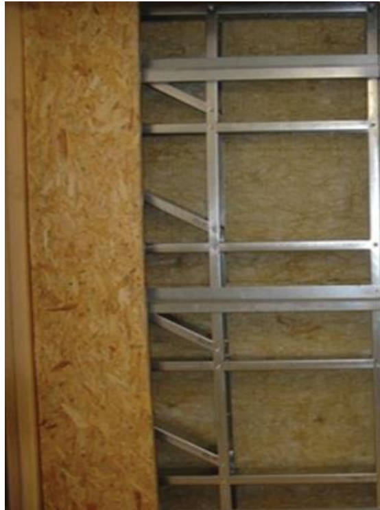
Slika 11: Oblaganje OSB ploče oko LSF-a [9]
