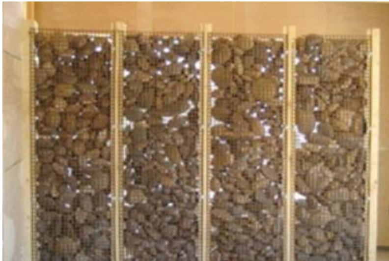
Slika 28: Zid od kamena [9]
