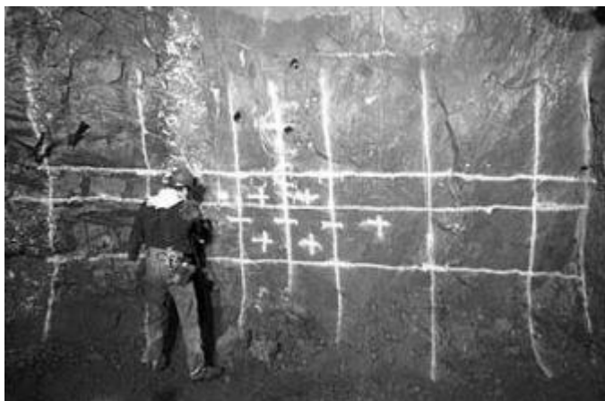
Slika 16 – ručno ocrtavanje pozicija bušotina za miniranje i stvaranje minskog polja [14]
