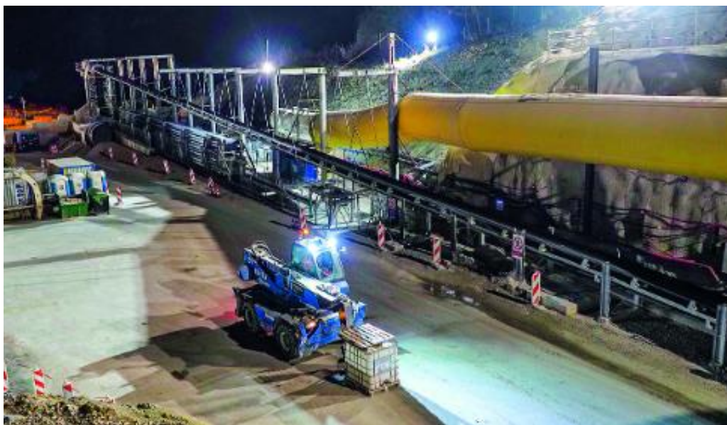
Slika 26- Istarska strana gradilišta- transportna traka REI- RBL TI [30]
