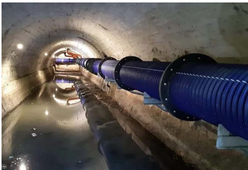
Slika 3 – primjer komunalnog tunela [8]
