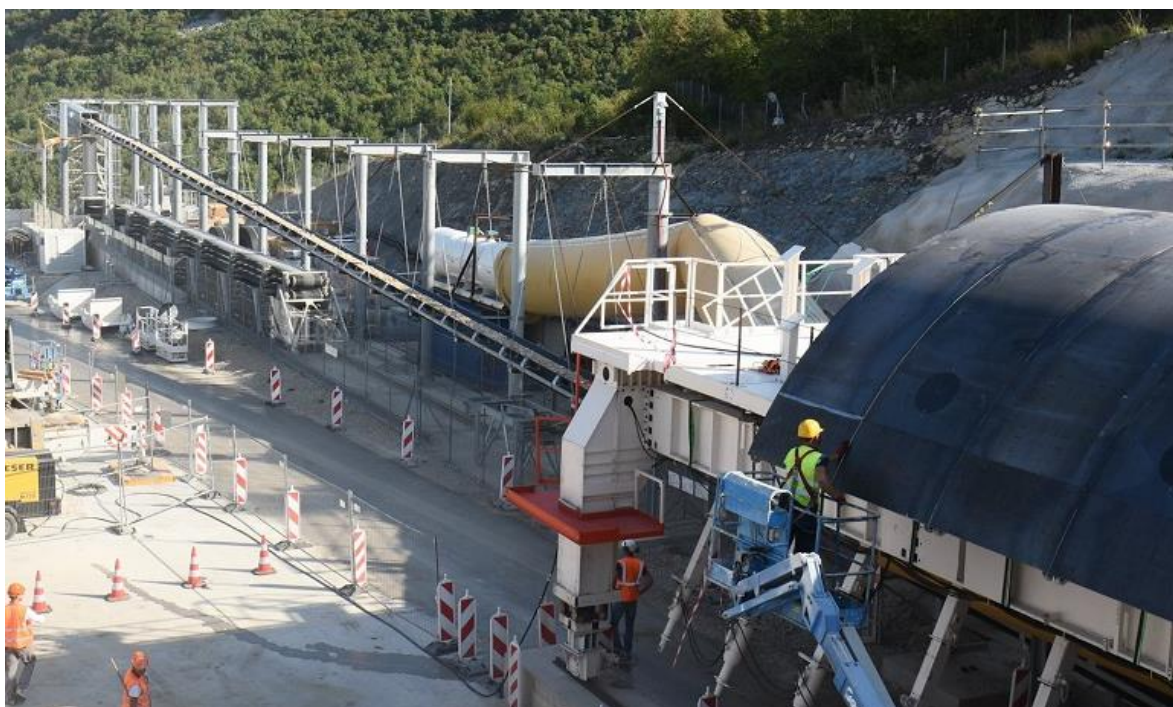
Slika 19 – transportna traka za odvoz usitnjene stijenske mase izvan okna tunela[23]
