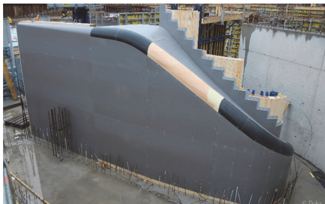
Slika 5. 3D ispisana oplata stubišta [31]
