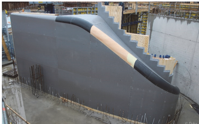
Slika 5. 3D ispisana oplata stubišta [31]
