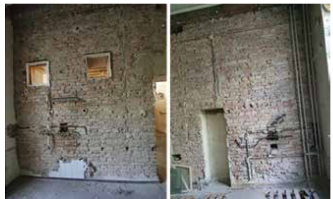
Slika 25. Karakteristični zidovi s otvorima i instalacijama
