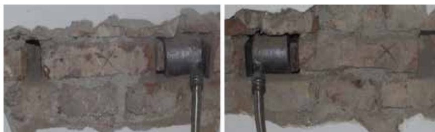
Slika 4. Stambeno-poslovna građevina, Ulica Ivana Dežmana 9 u Zagrebu, ispitivanje posmične čvrstoće ziđa na mjestima Z4 i Z6
