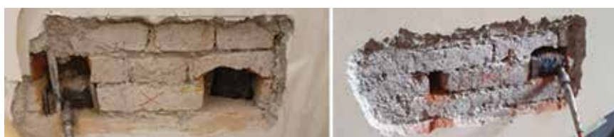
Slika 8. Hotel Palace, Ispitivanje posmične čvrstoće zida na 1. katu na mjestima 1-1 i 1-7
