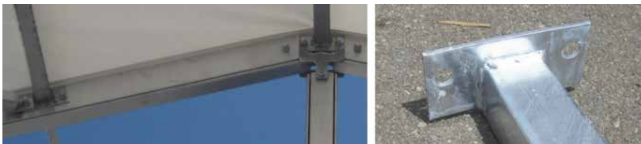
Slika 15. Čelični sekundarni nosač
