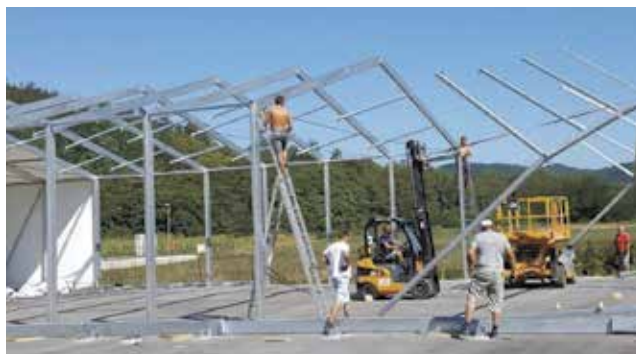
Slika 2. Montaža aluminijske hale
