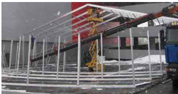
Slika 19. Podizanje okvira i povezivanje s ostatkom konstrukcije
