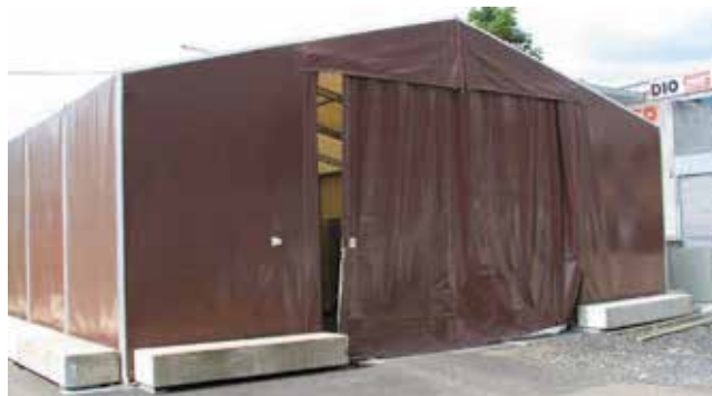
Slika 11. Osiguranje stabilnosti konstrukcije blokovima za sidrenje
