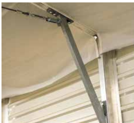
Slika 14. Priključak prečka-stup, varijanta s rukom i zategom
