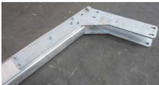
Slika 12. Priključak prečka - stup s čeličnim pločama [8]
