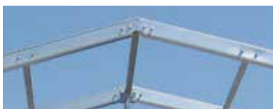
Slika 13. Priključak prečka - prečka s čeličnim umetkom
