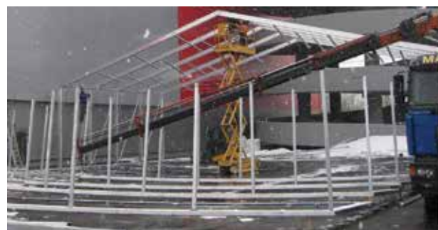
Slika 19. Podizanje okvira i povezivanje s ostatkom konstrukcije
