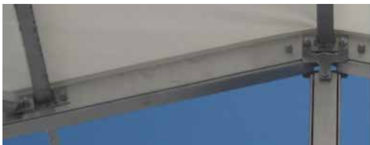
Slika 15. Čelični sekundarni nosač
