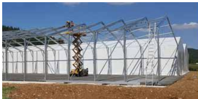
Slika 20. Montaža sekundarnih elemenata i stabilizacija
