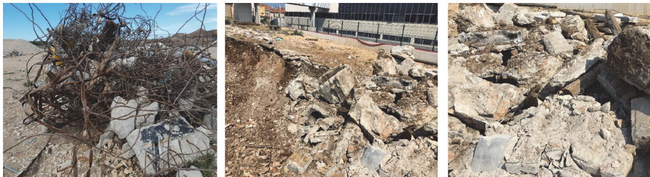
Slika 3. Otpad od rušenja postojeće građevine
