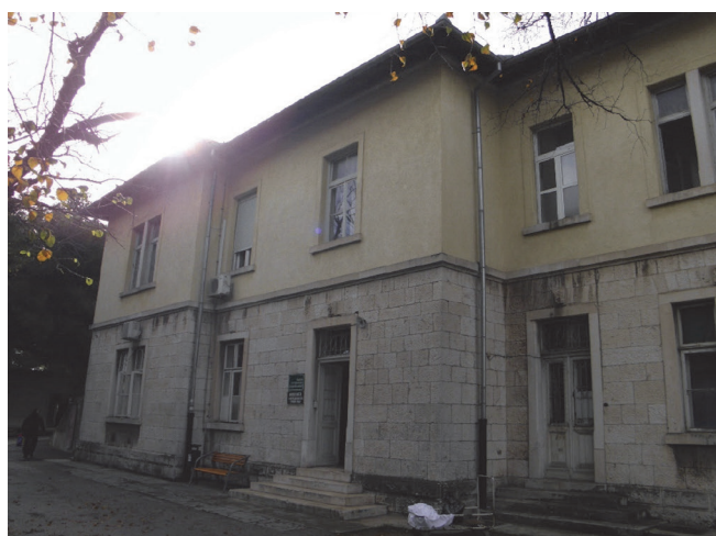
Slika 1. Stara zgrada infektologije OB Zadar predviđena za rušenje
