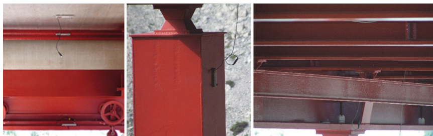
Slika 15. Senzori za mjerenje relativnih deformacija na Masleničkom mostu [31]
