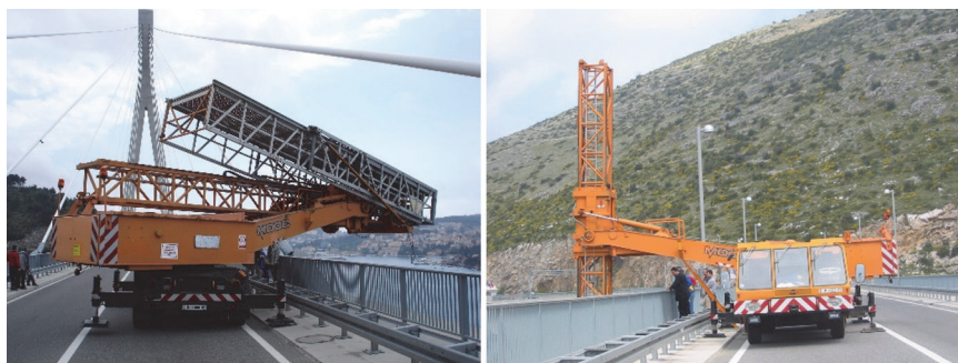
Slika 11. Pregled mosta Franje Tuđmana u Dubrovniku, 2005. godina [28]
