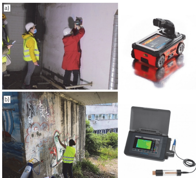
Slika 9. a) Lociranje armature i određivanje debljine zaštitnog sloja georadarom StructureScan Mini XT, b) Mjerenje polučelijastog potencijala uređajem Profometer Corrosion
