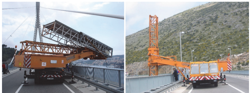
Slika 11. Pregled mosta Franje Tuđmana u Dubrovniku, 2005. godina [28]
