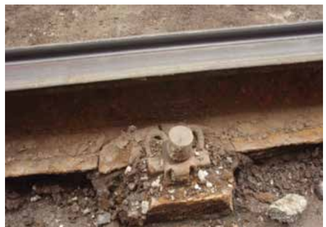
Slika 12. Razaranje nožice tračnice na mjestu pričvršćenja na kolosijeku ugrađenom u cestovnu prometnicu
