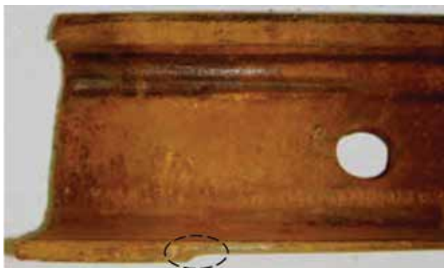
Slika 10. Ispitivani uzorak korodirane tračnice, gubitak materijala s donje strane nožice tračnice; zaokružena mjesta predstavljaju mjesta koncentracije najvećih normalnih naprezanja [31]
