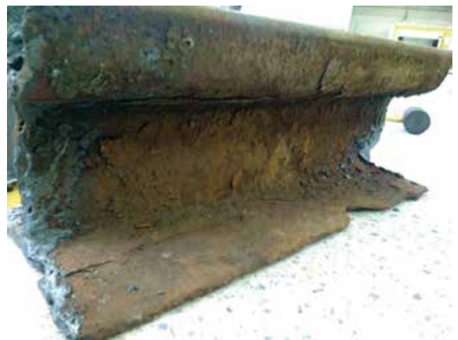
Slika 11. Korozija cijelom duljinom nožice i vrata tračnice, uzorak tračnice iz kolosijeka ugrađenog u cestovnu prometnicu
