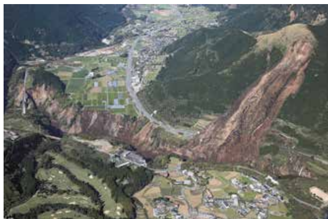
Slika 8. Klizište pokrenuto uslijed Kumamoto potresa magnitude 7,0, iz travnja 2016., preuzeto iz [25]
