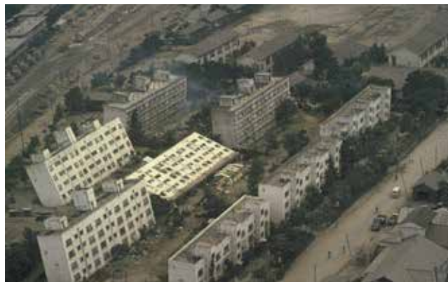
Slika 6. Nagnute zgrade na likvefiranom tlu u Niigati (Japan) u potresu 1964. godine, preuzeto iz [18]
