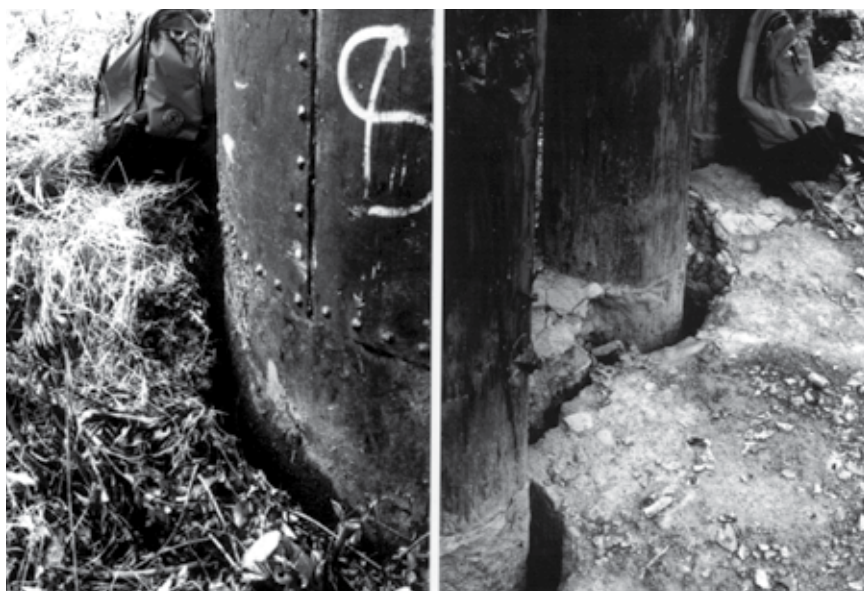
Slika 12. Pukotina uz vrh pilota kao posljedica cikličnog opterećenja pilota u glini, prema [56]
