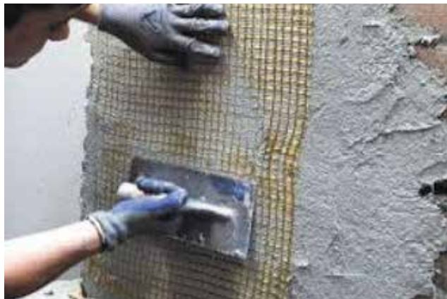
Slika 5. Nanošenje TRM-a [26]
