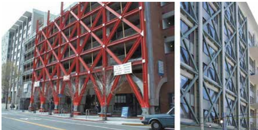
Slika 8. Zgrade ojačane vanjskim čeličnim vezovima
