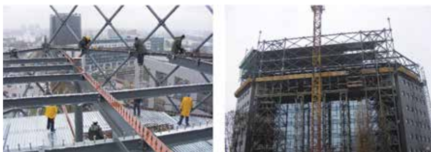
Slika 3. Vertikalna nadogradnja - zgrada Euroherc, Zagreb
