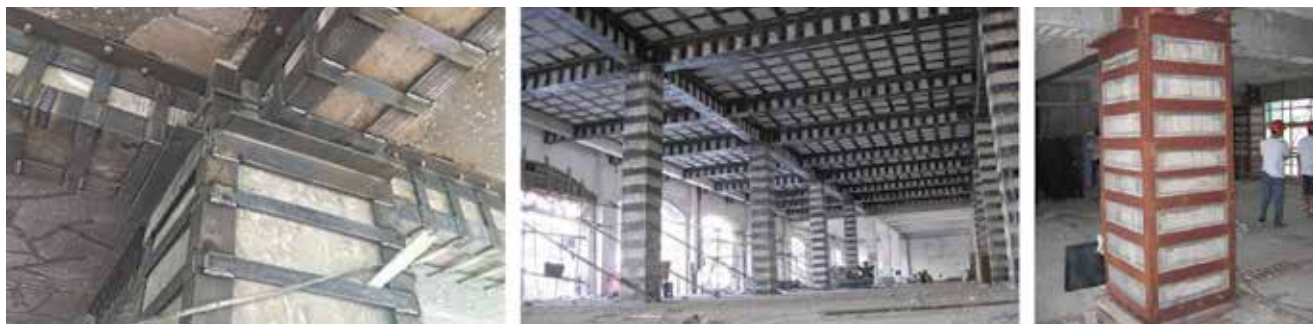
Slika 10. Ojačanje armiranobetonskih elemenata čeličnim pločama
