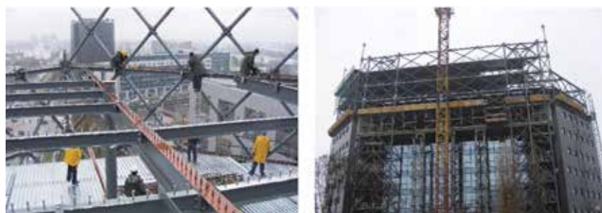
Slika 3. Vertikalna nadogradnja - zgrada Euroherc, Zagreb
