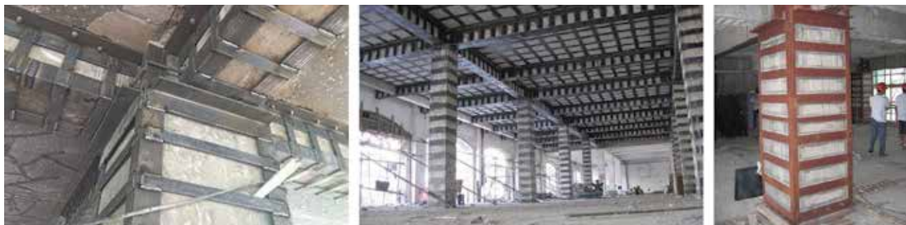
Slika 10. Ojačanje armiranobetonskih elemenata čeličnim pločama
