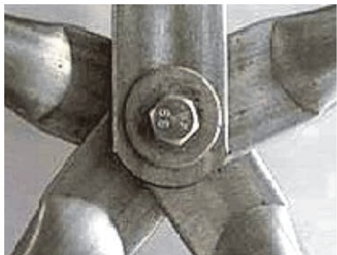
Slika 3. Neka rješenja čvorova čeličnih geodetskih kupola [5]
