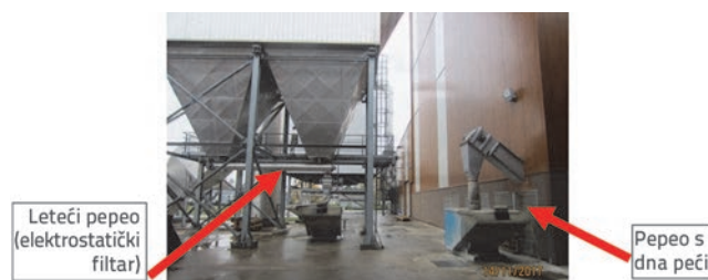
Slika 5. Primjer prikupljanja pepela s dna peći i letećeg pepela u energani Slavonija DI d.o.o., Slavonski Brod, Hrvatska
