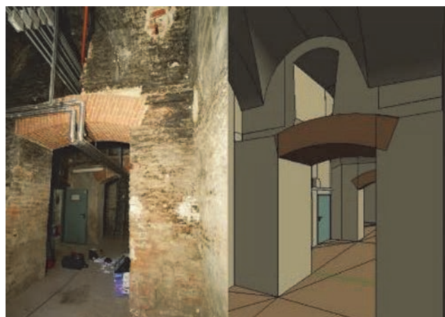
Slika 4. BIM modeliranje nepravilnog zida u dvorcu Valentino [33]
