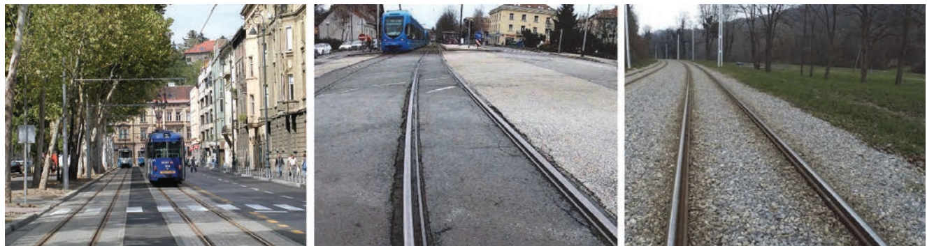
Slika 5. Zatvaranje kolosijeka na dionici 2 – AB ploče (lijevo), asfalt (u sredini), kameni agregat (desno)
