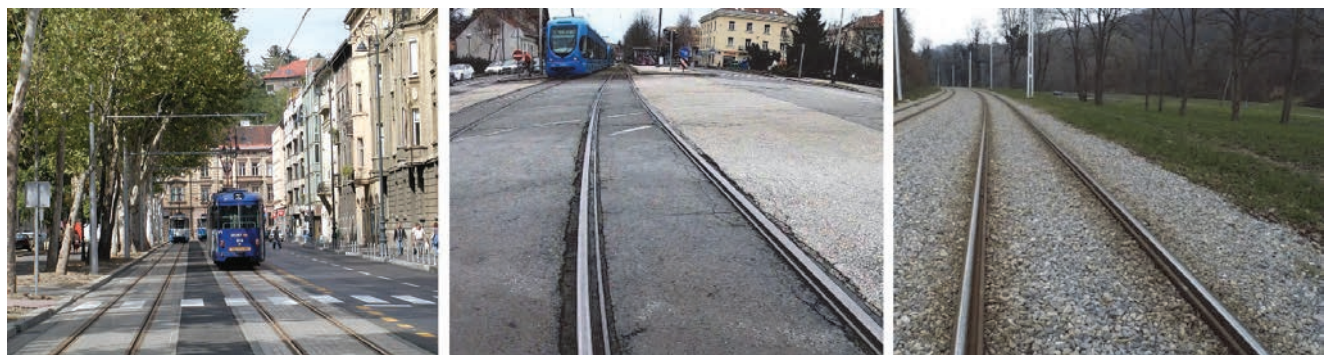
Slika 5. Zatvaranje kolosijeka na dionici 2 – AB ploče (lijevo), asfalt (u sredini), kameni agregat (desno)
