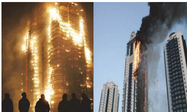
Slika 1. Razorno djelovanje požara na čelične konstrukcije
