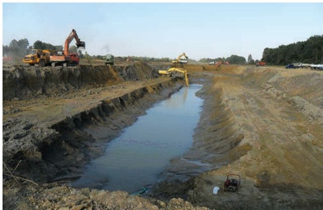
Slika 6. Izvedba radova na iskopu kanala [13]
