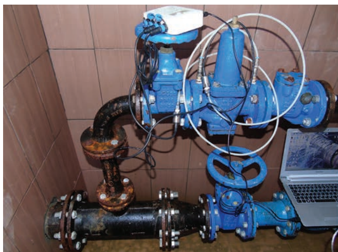
Slika 8. Testirani opružni regulatori u prvoj (lijevo) i drugoj (desno) kampanji
