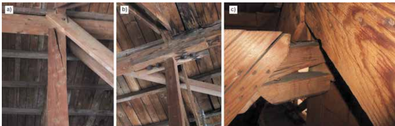
Slika 11. a) Uzdužne raspukline vertikalne rešetke zbog prekoračenja opterećenja; b) Raspukline uzrokovane skupljanjem i bubrenjem drva; c) Detalj s upitnom nosivosti zbog nepravilnog načina oblikovanja ili manjka spojnih sredstava
