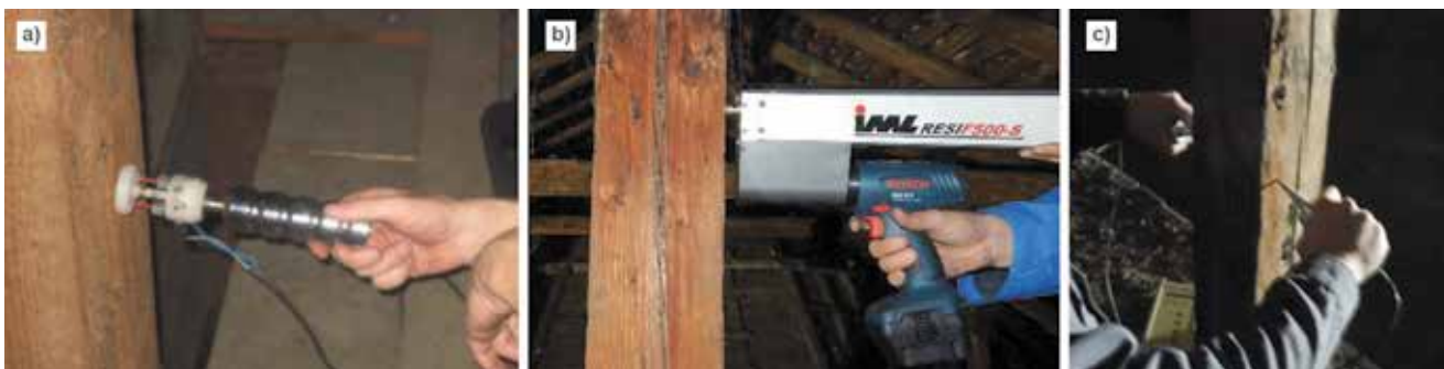
Slika 10. a) Mjerenja količine vlage; b) bušenje i mjerenje otpora prodiranja rezistografom; c) ultrazvučna mjerenja
