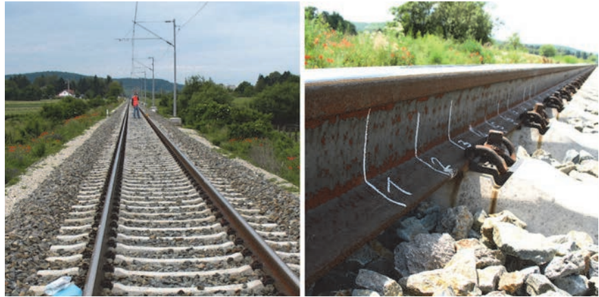
Slika 10. Jednokolosiječna željeznička pruga Koprivnica - Križevci (lijevo) i ugrađena tračnica 60E1 (desno)
